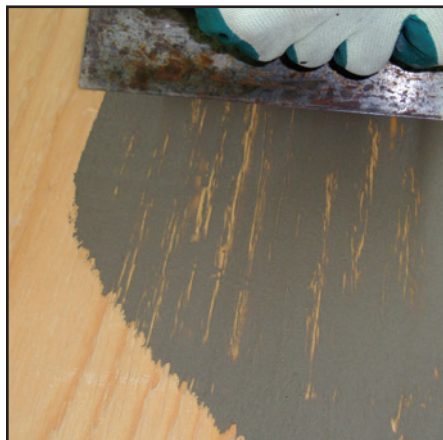
PRO FINE PATCH™ utilisé comme produit de resurfaçage au-dessus du contreplaqué
